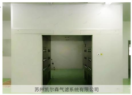
未来风淋室的发展趋势是智能语音风淋室,带有语音提示系统,在吹淋周期由自动语音系统提示让工作人员有秩序的完成整个吹淋除尘过程,达到更有效有秩序的净化过程和效果。智能语音风淋室的主要特点包括:全自动控制,智能语音控制,感应控制,电子互锁装置,吹淋开始时双门自动锁闭,人员进入后红外线感应自动吹淋。不锈钢半玻璃门自动闭门器,透明视窗,内部地板板为不锈钢材质,软件控制器□LED触摸控制显示屏,使用者可自主设置吹淋时间,吹淋时间范围0~99秒可调,内部采用圆的渐开线风道,高风速吹淋,低噪音运行。智能语音控制风淋室是电子洁净室、制药行业、精密仪器等行业的更佳选择,在未来将得到更多的应用。自动门风淋室哪家好?上海风淋室加工
